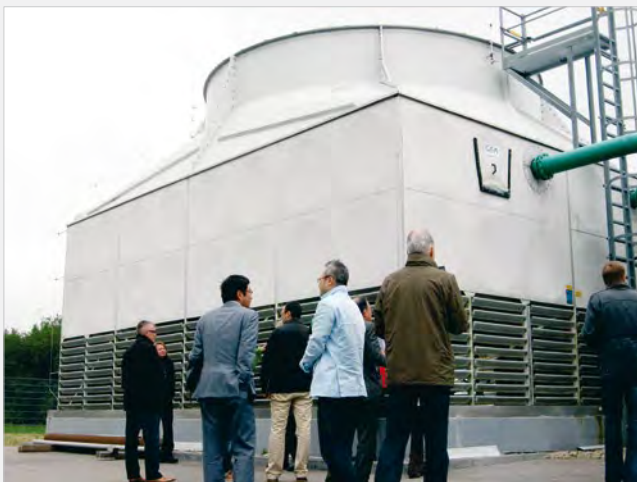
Die Kalina-Anlage des Geothermiekraftwerks in Bruchsal. Foto: Marcus Brian, Enerchange.
